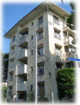
写真：旧来街区住棟
